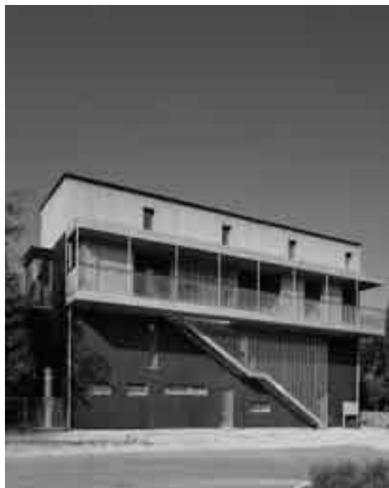
7. Casa Hitthaler, facciata sud (foto Jürgen Eheim). 8 casa Hitthaler, facciata nord (foto Jürgen Eheim).
