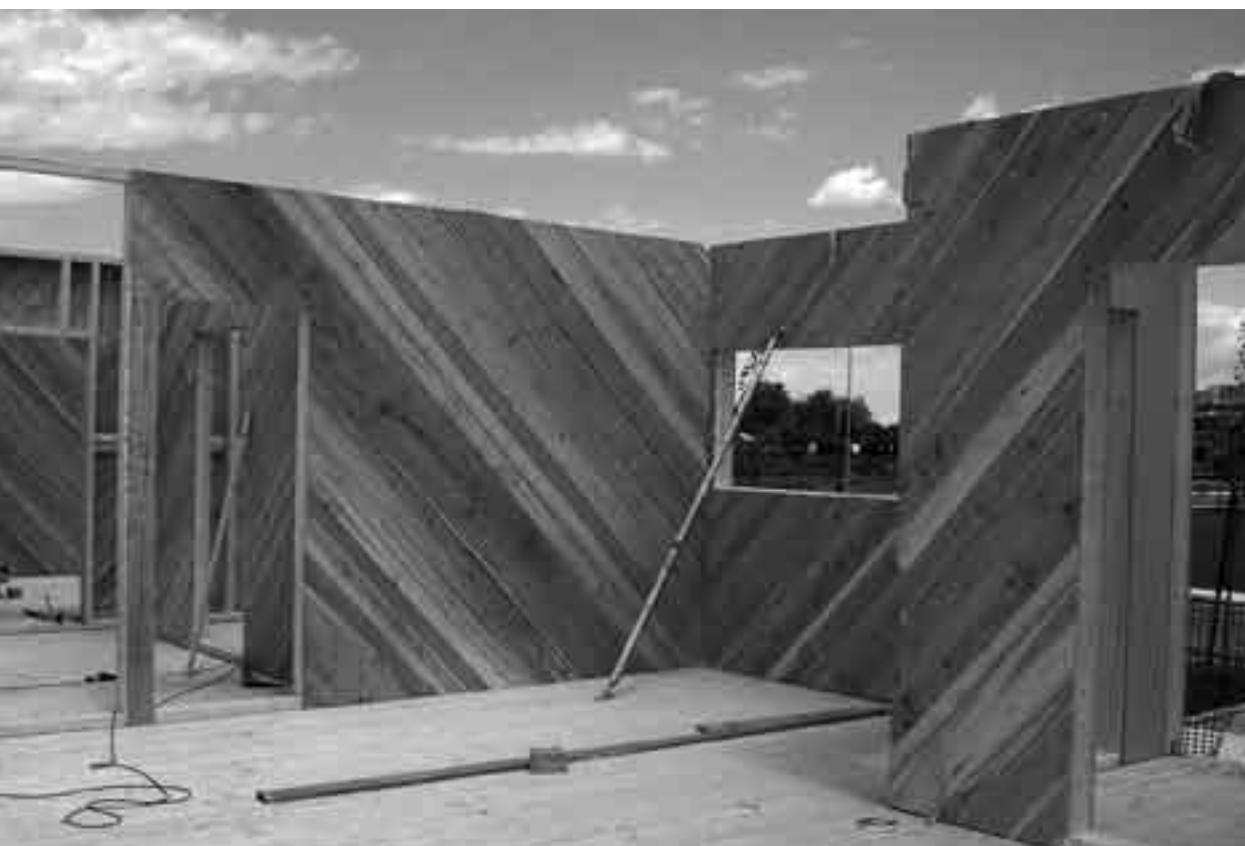
5. Casa Baccichetto, Ceggia (Venezia) di Giovanni Antonio Brunello; vista del cantiere.
