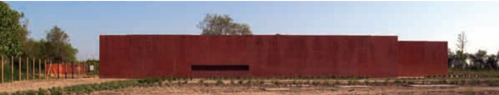
DEPURATORE DI SANT'ERASMO. 3-4. Il depuratore nel paesaggio dell'isola di sant'Erasmus (foto: Pietro Savorelli) 5. Il depuratore nel paesaggio dell'isola di Sant'Erasmus (foto: Carlo Cappai) 6. Schizzo di progetto
