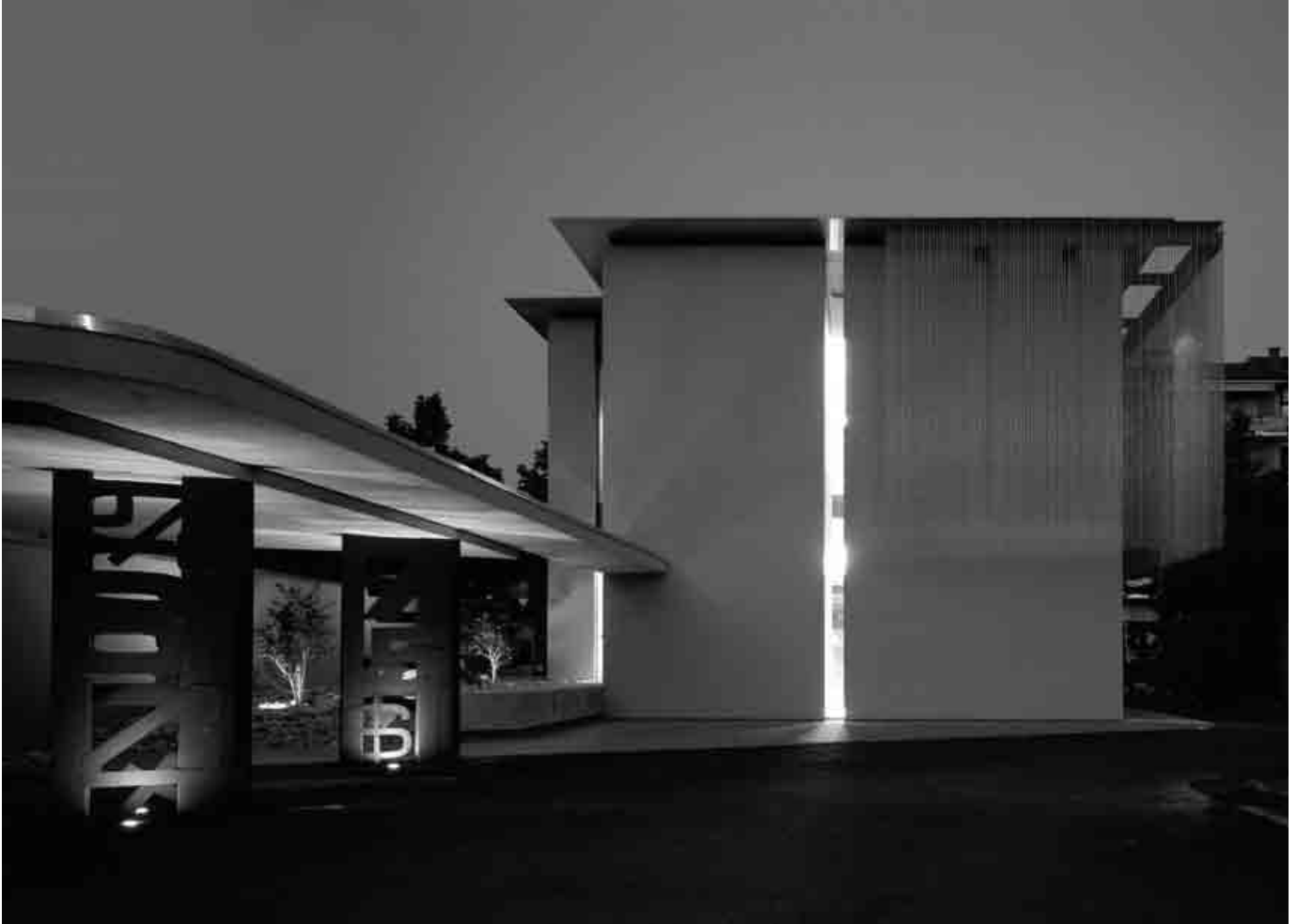
6. Veduta serale del fianco dell'edificio
