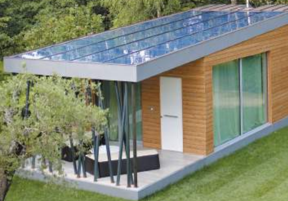
02 | La suite vista dall'alto con il suo impianto fotovoltaico a bordo
